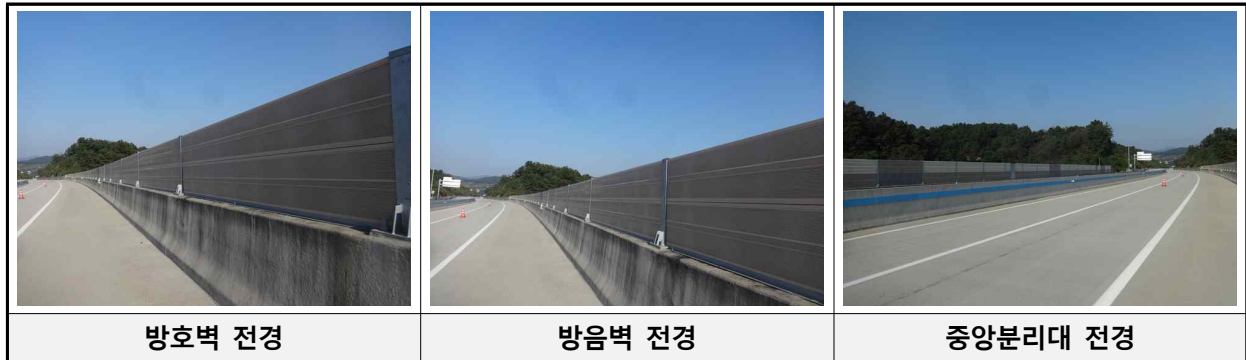
[방호벽 및 방음벽 전경]
