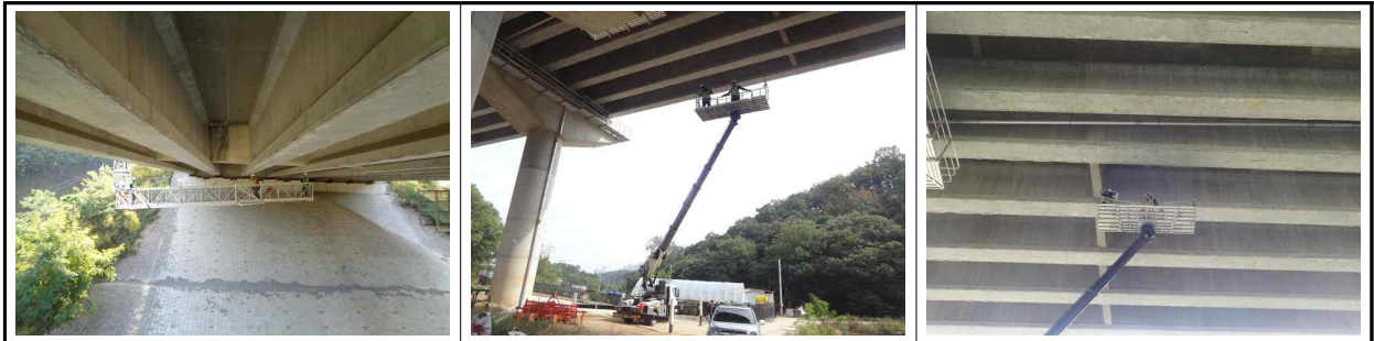
[고소작업차, 굴절점검차를 이용한 근접조사 실시]
